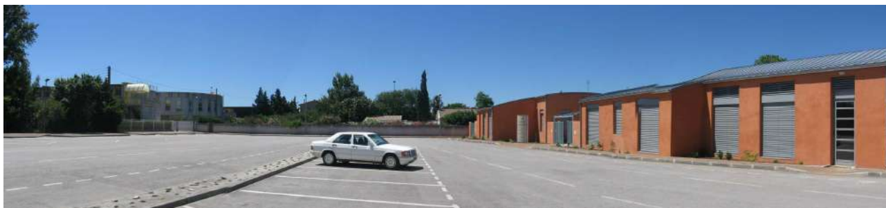
Collège Saint-Exupéry et le parking qui a notamment été refait
